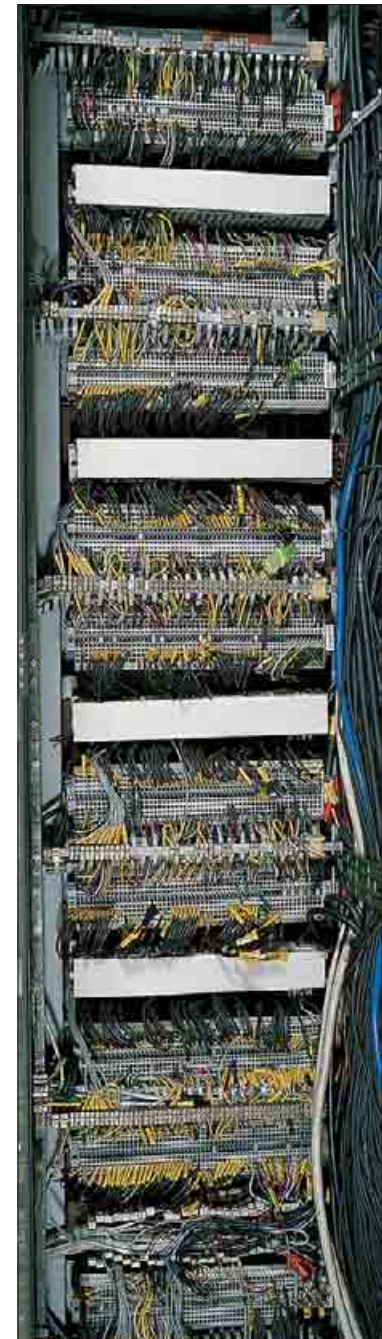
Рис. 14. Шкаф управления с клеммами WAGO на железной дороге в Германии
