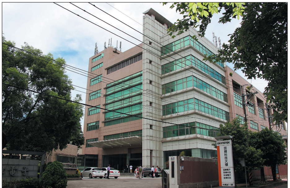
Производственный корпус компании GOOD WILL
