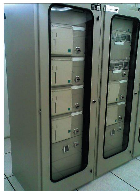
Рис. 5. Терминалы МУРЗ, установленные в стандартных шкафах со стеклянными дверями
