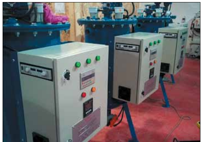
Рис. 10. Система электростабилизационной подготовки воды с использованием источников GENH40-19
