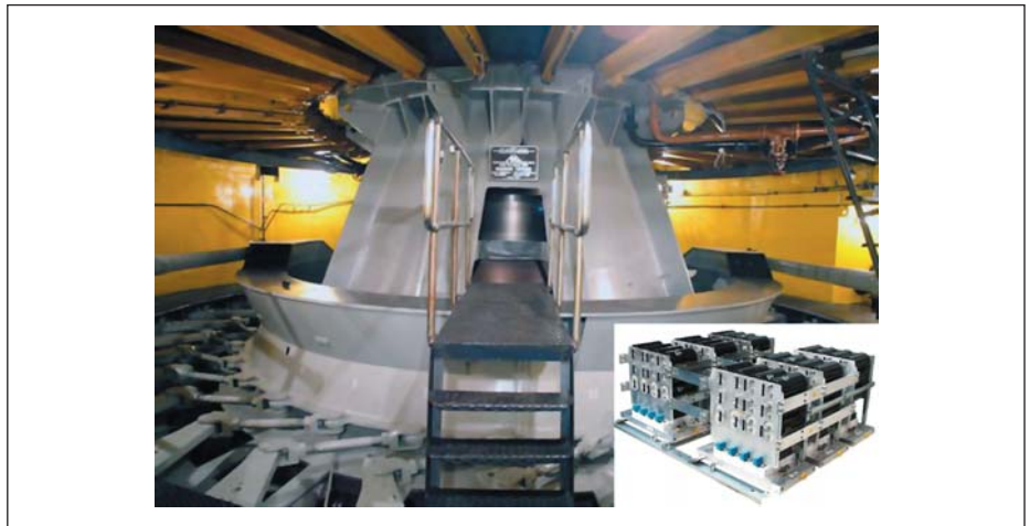
Рис. 12. Гидротурбина и силовая сборка преобразователя мощностью 1500 кВА
